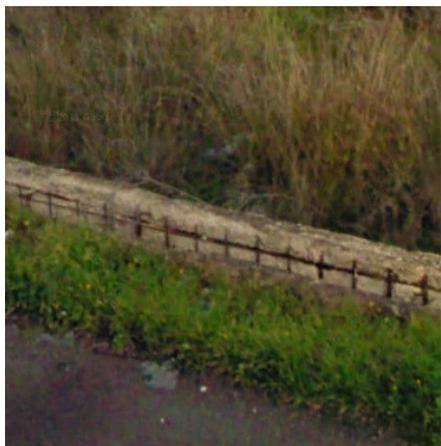
stato di ammaloramento della canaletta ad U sul margine sinistro
