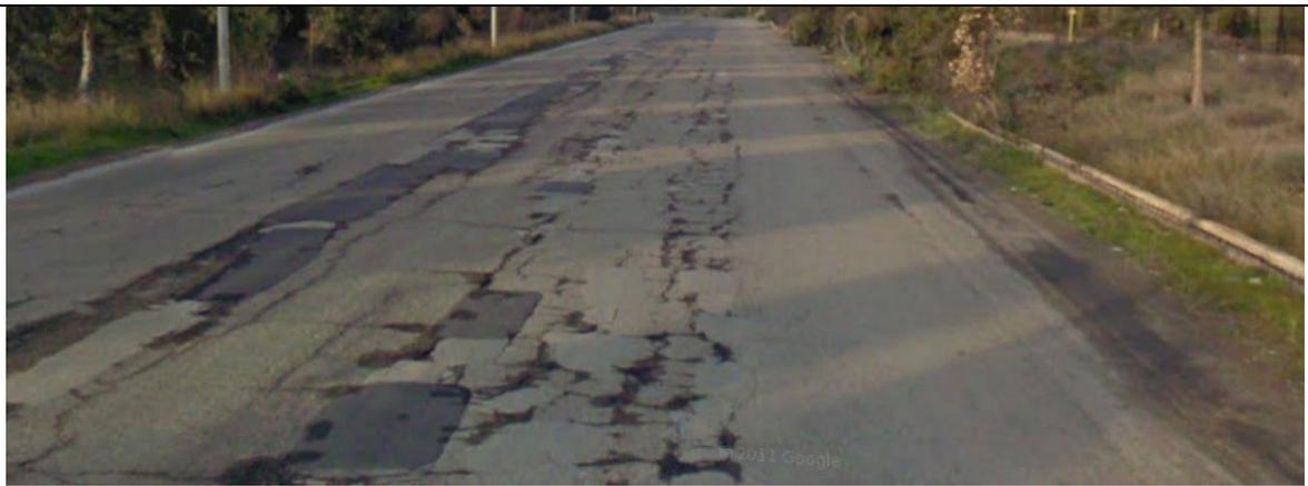
stato di ammaloramento della pavimentazione stradale
