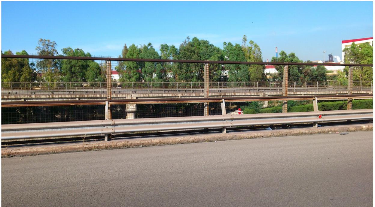
Foto 5: guardrail e recinzione di protezione sulle rampe nord e sud.
